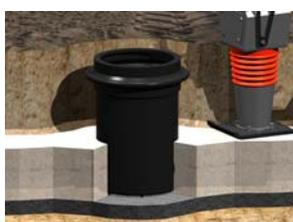
El material de relleno debe ser colocado de forma uniforme alrededor de todos los lados de la arqueta, hasta alcanzar el nivel de la boca superior. Este se colocará en tongadas de aproximadamente 30cm, compactando adecuadamente cada tongada hasta alcanzar la densidad requerida por el proyecto (mínima equivalente al 90% del Proctor Standard).
